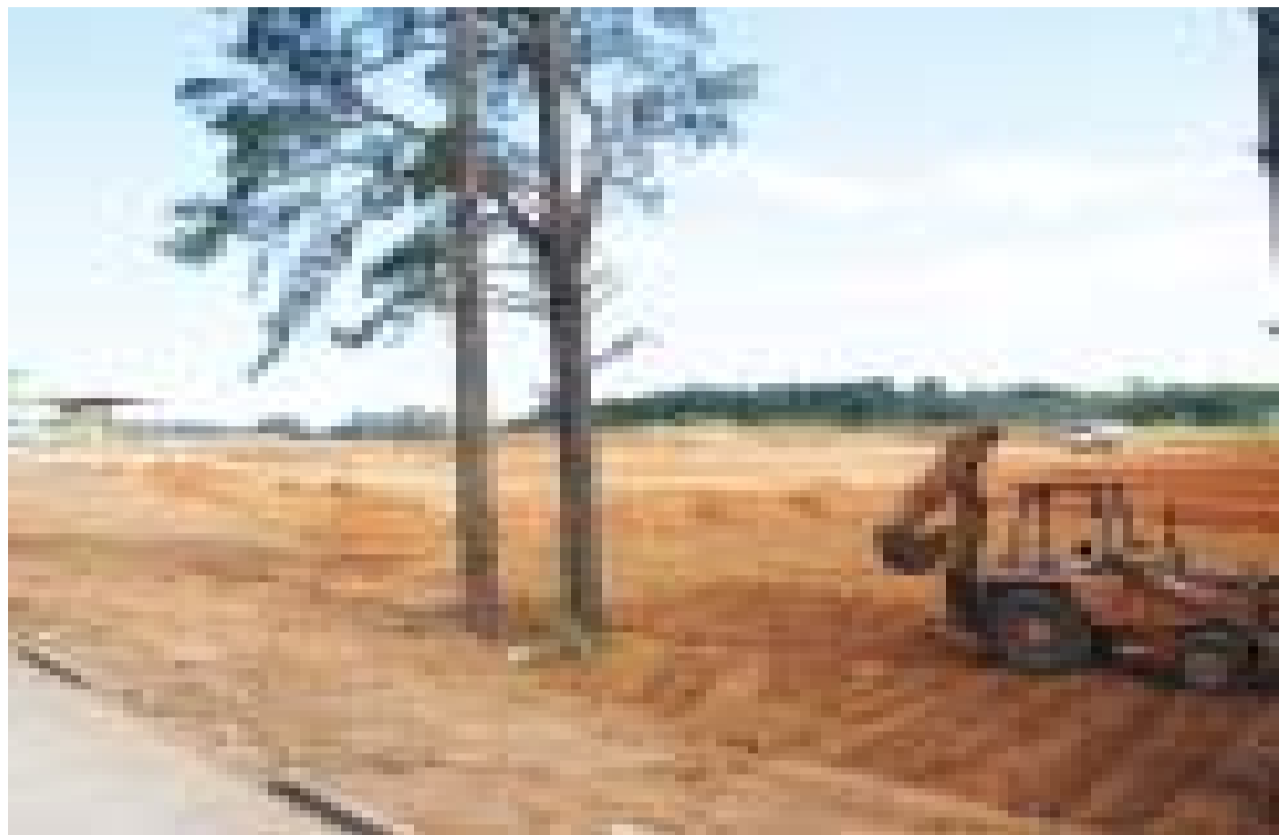
Máquinas nivelam terreno onde será construído o shopping, ao lado da empresa Dongwoo
